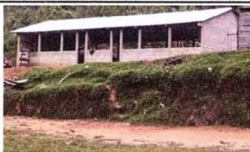
Foto 5: estructura nuava de la EORM CASERIO RIO IMPOSIBLE
