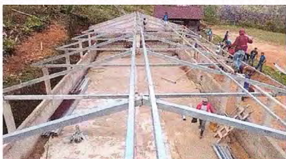
Foto 3: la vigas y tijeras nuevas de metal
