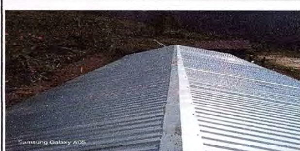
Foto 4: techo nuevo del edificio.
