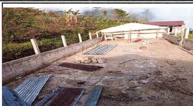
Foto 2: la obra esta a un 50% de seguimiento, muro y parales nuevas
